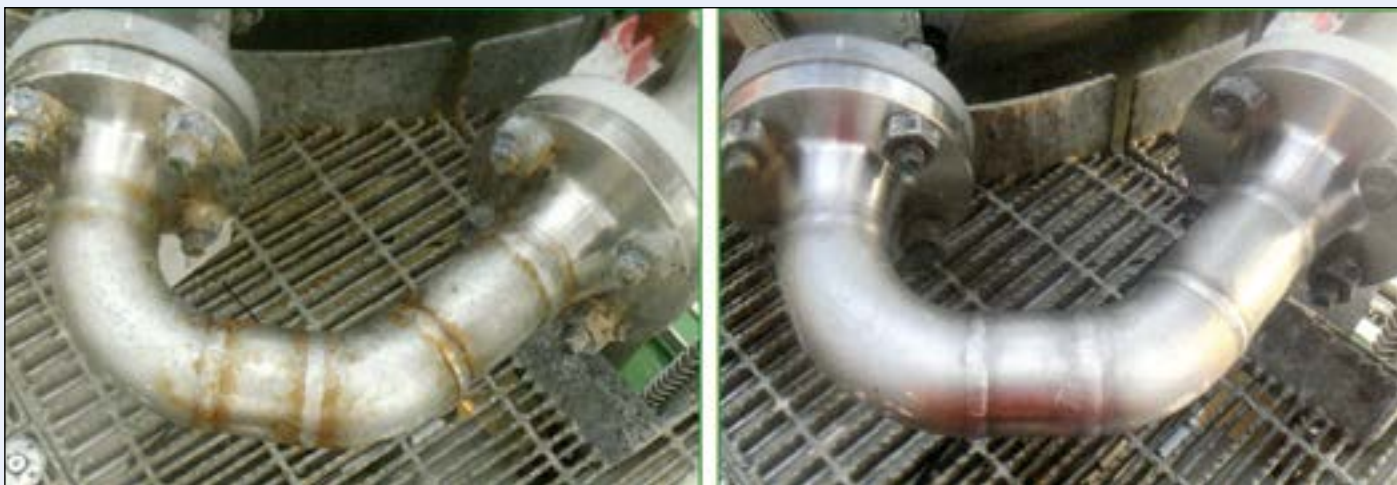
Rustfritt rør før og etter påføring av termorens GEL.
