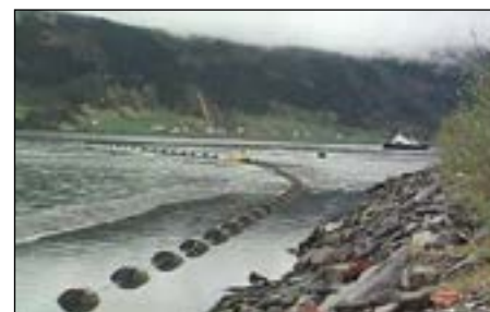
Hovudprinsippa er å føre lavtemperert sjøvatn (ca 8 - 12 oC) frå 50 meters djup i Eidsfjorden til lands.
