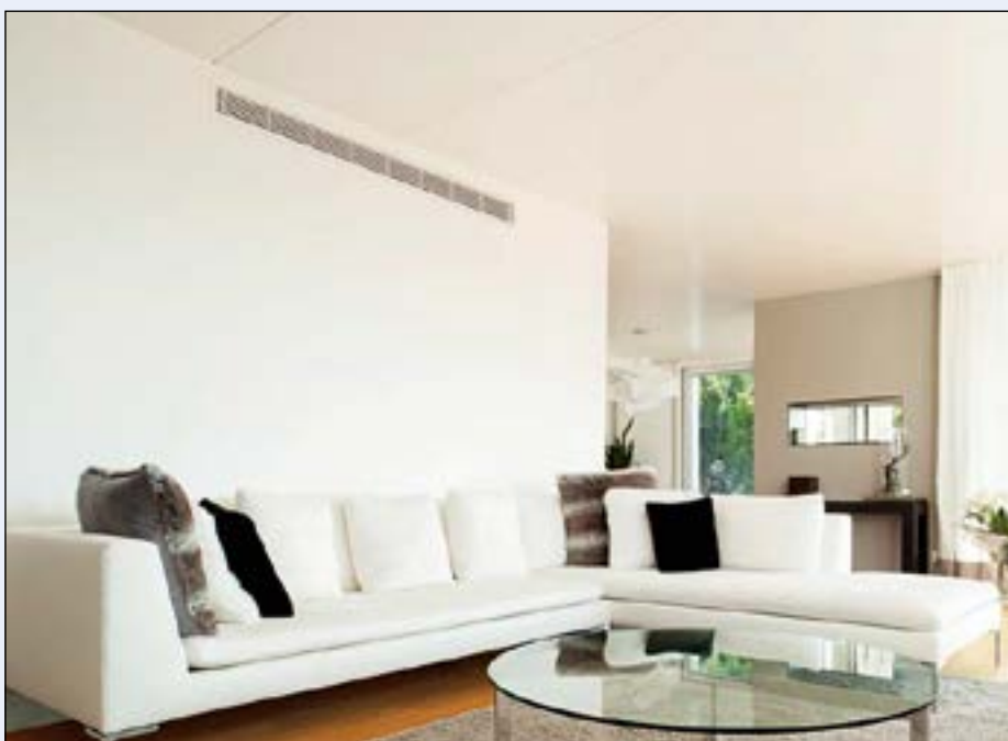
Dette er vel løsningen for alle dem som ikke orker å se innedelen på en varmepumpe.
