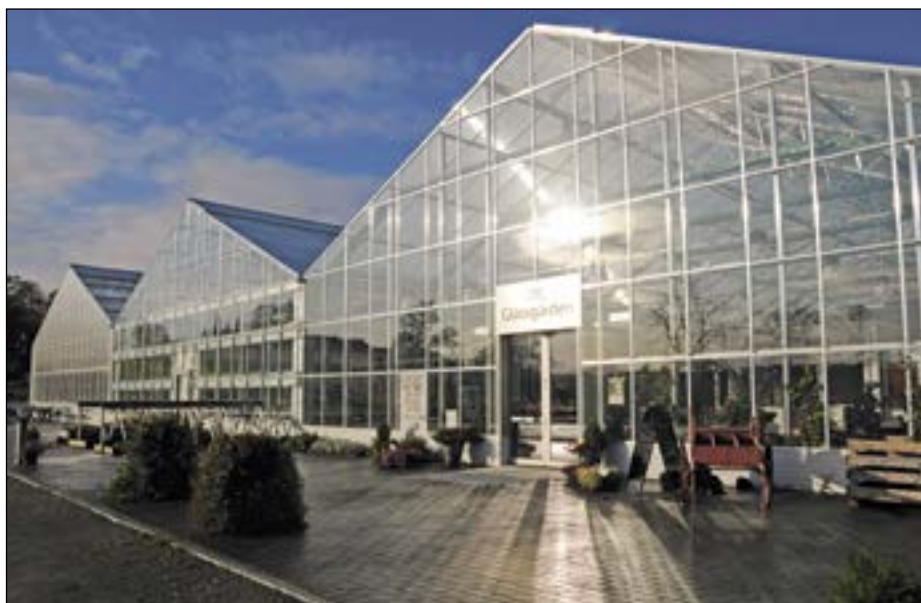
På Mære landbruksskole i Trøndelag har man bygget en helt ny type veksthus som er en energi- og klimarevolusjon.
