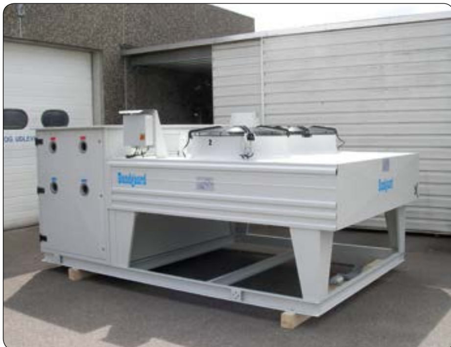
Hos LMG i Kolding valgte man i forbindelse med opførelsen af deres nye centrallager/administrationsbygning at benytte sig af en løsning med propan som primært kølemiddel til afkøling af luft i deres ventilationssystem.
